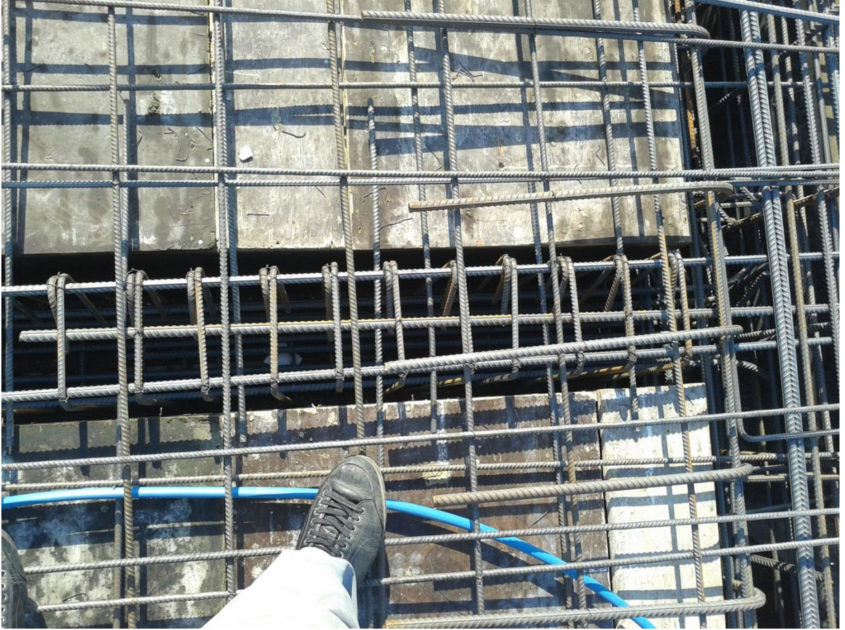
Fotoğraf 5: Kiriş Boyuna Donatılarının Kontrol Edilmesi
