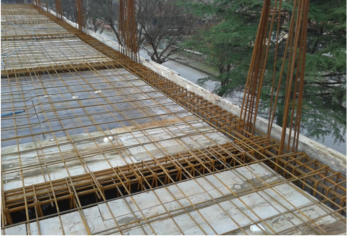
Fotoğraf 8 : Kiriş Etriyelerinin Kontrol Edilmesi
