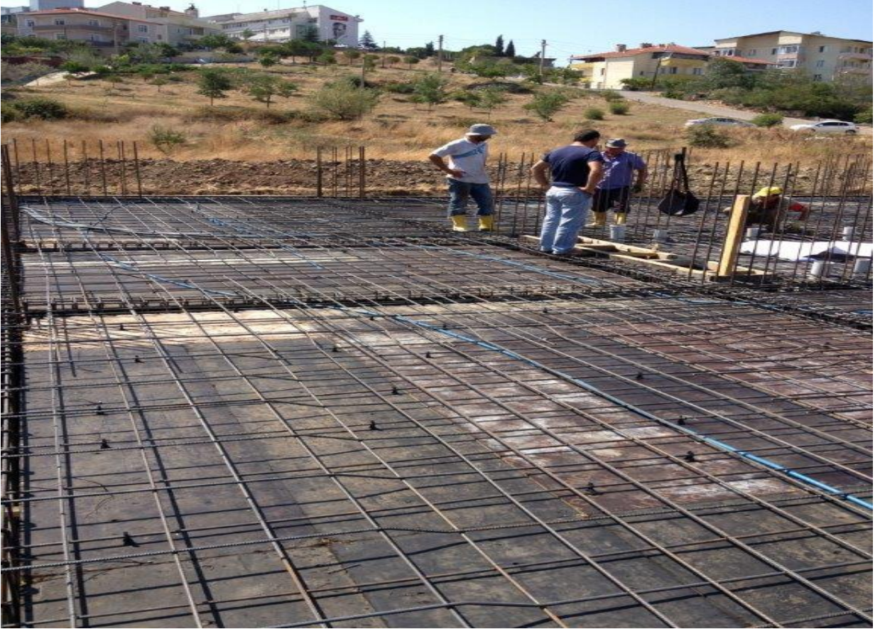
Fotoğraf 12: Pas paylarının Kontrol Edilmesi
