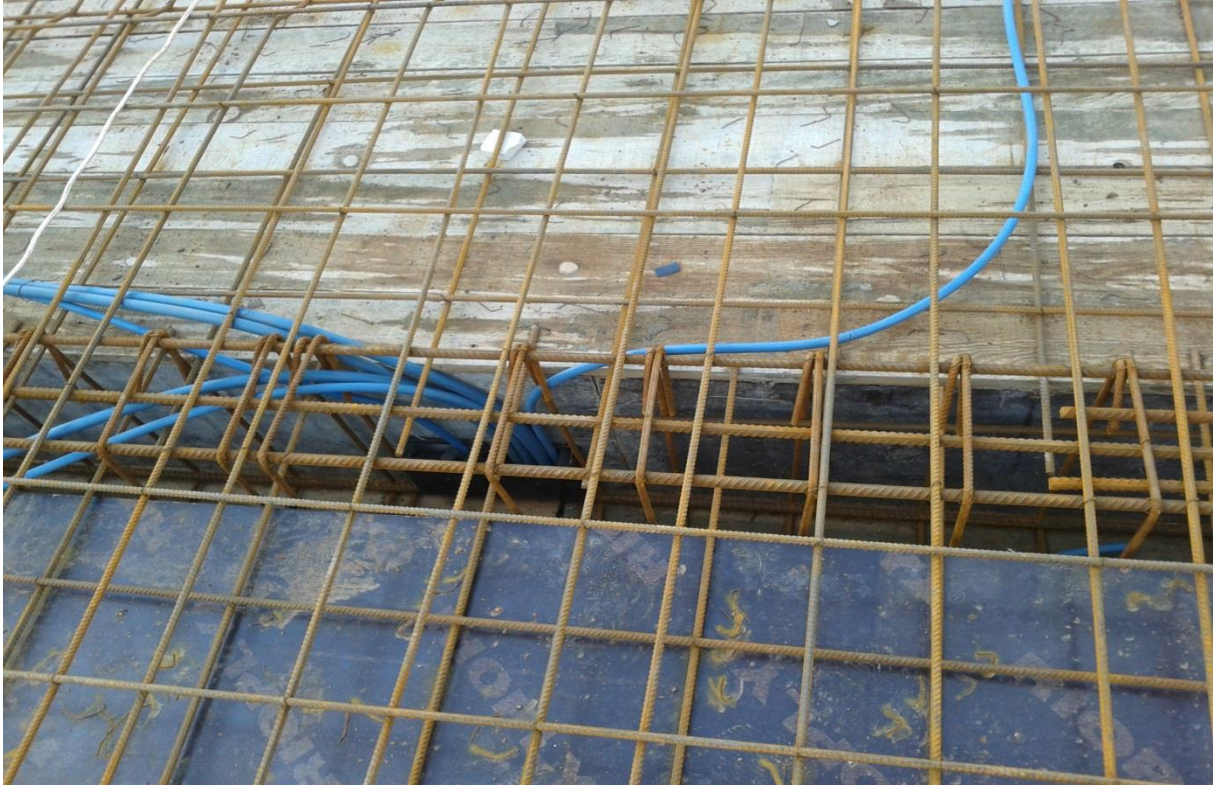
Fotoğraf 9 : Kiriş Etriyelerinin Kontrol Edilmesi
