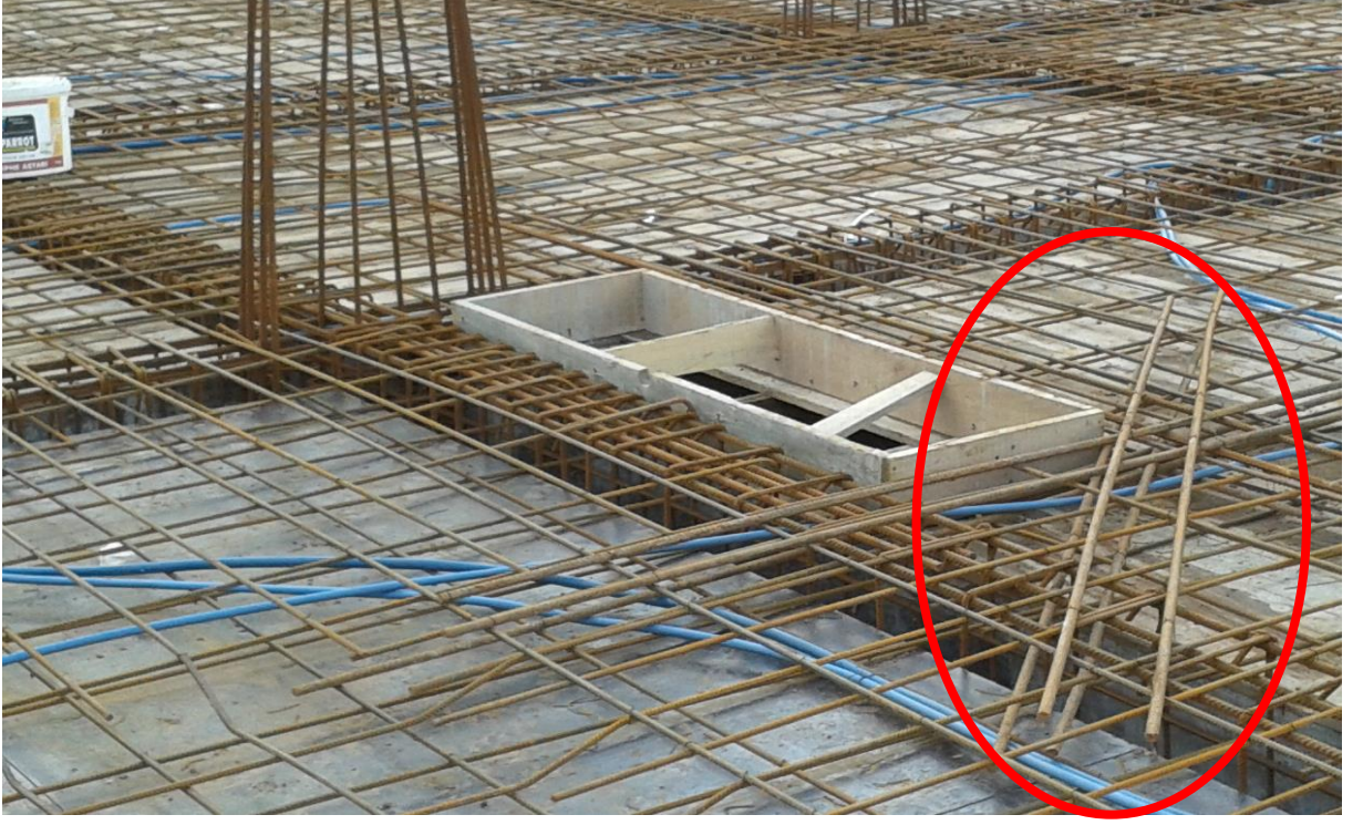
Fotoğraf 11: Döşeme Boşluk Donatılarının Kontrol Edilmesi
