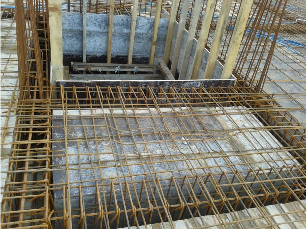
Fotoğraf 10: Döşeme Donatılarının Kontrol Edilmesi
